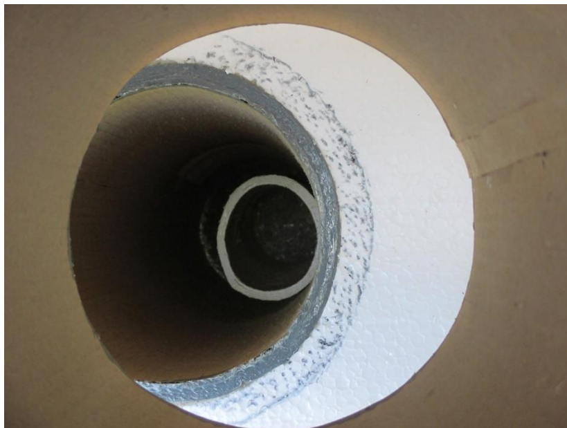
Foto 1 : Situatie met 13 cm inzakking van het onderste buisdeel + kalksteenlaag (zie foto 3 en 5)
